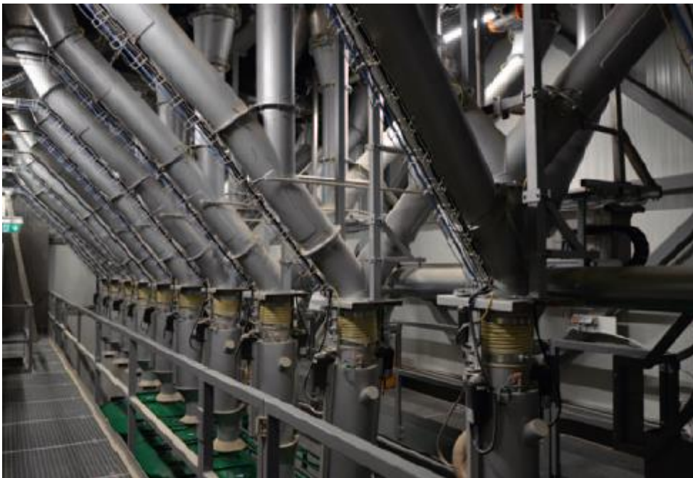
Fallrohre unter den Kontrasets.
